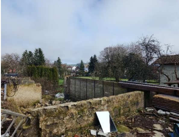
Abb. 3: Abgerissenes Wohnhaus (Gartenweg 7), Blick Richtung Nordosten
